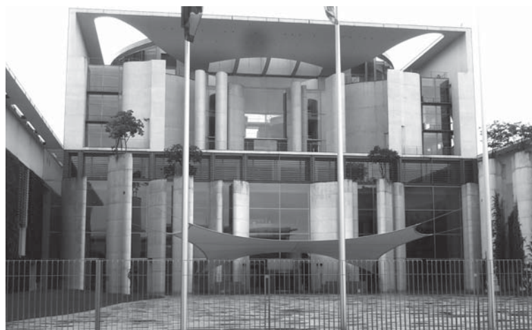
Regierungsviertel in Berlin: Betonbau Kanzleramt
