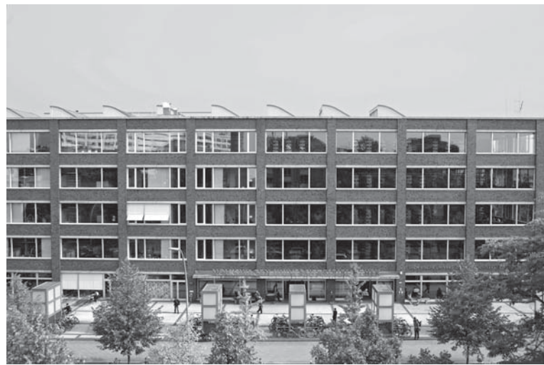
Auf dem Dach der TU-Bibliothek wurde die Solaranlage installiert.
