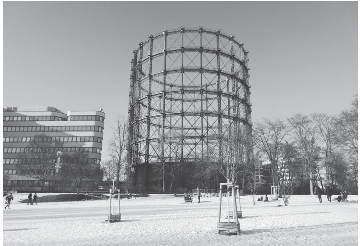
Noch ist der Gasometer offen. Unten die Veranstaltungshalle, in der Günther Jauch seine Talkshow im Ersten moderierte.
