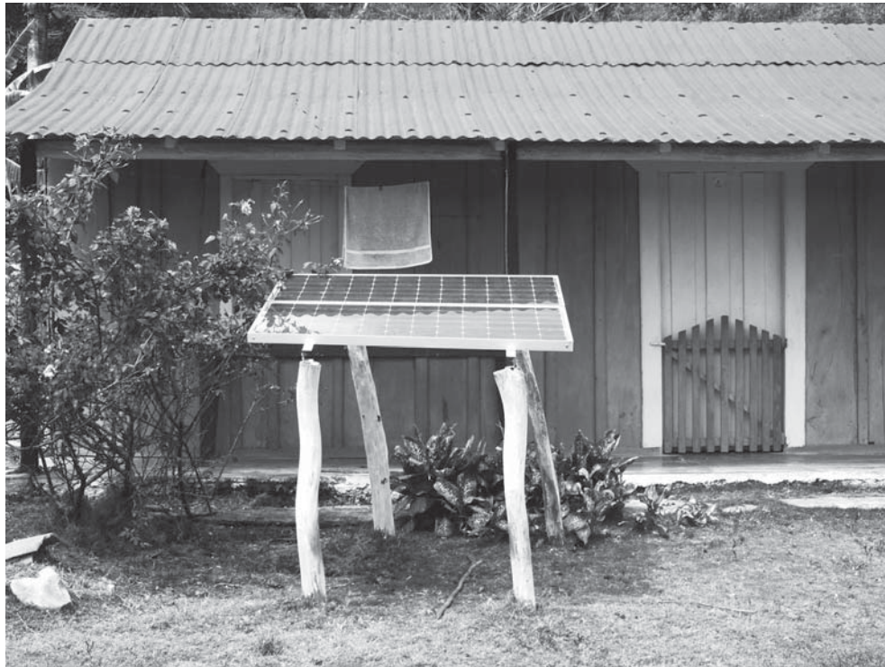
Solarmodul in einem abgelegenen Tabakbauernhof.
